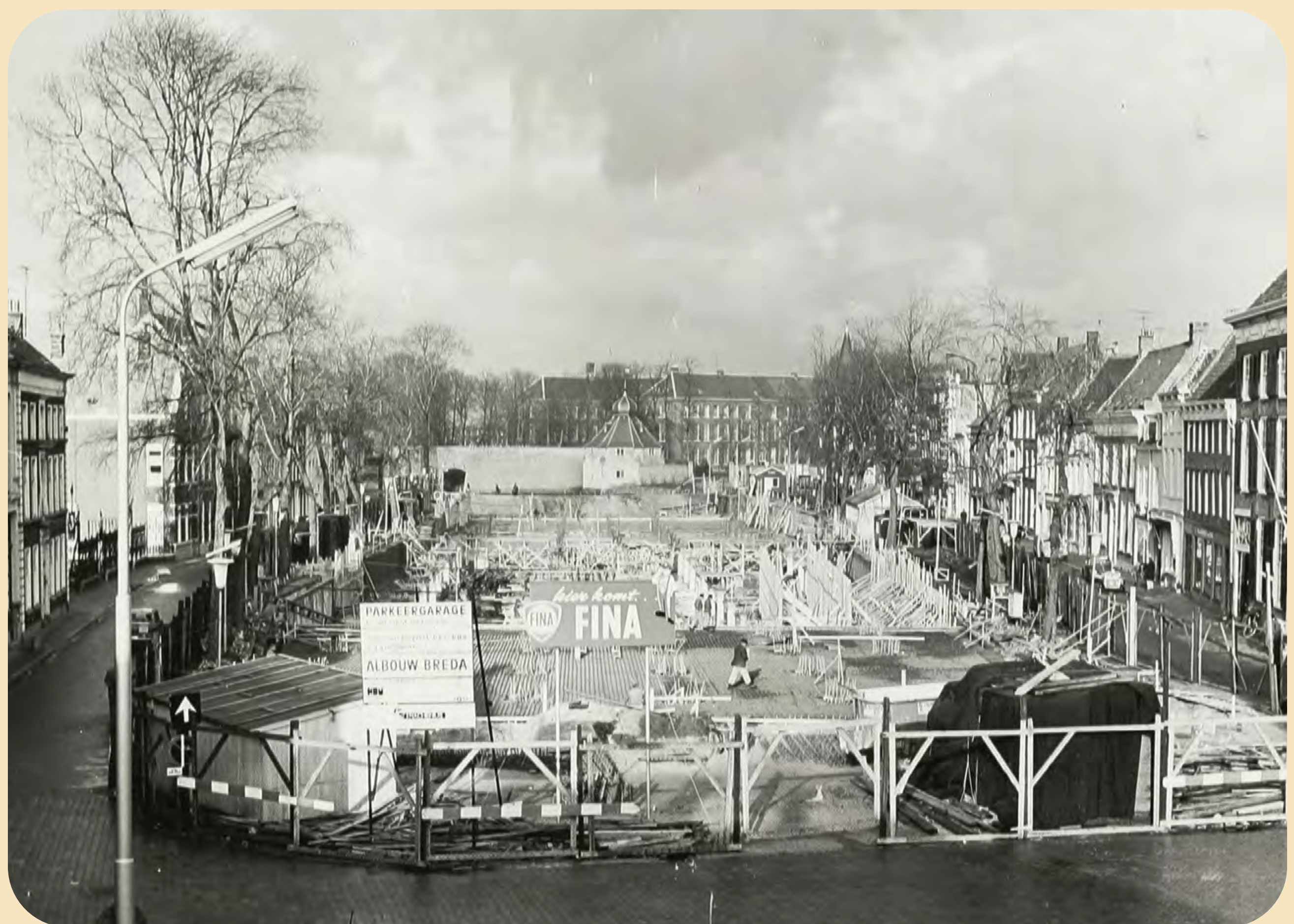
De bouw van de ondergrondse parkeergarage. Met op de achtergrond het Spanjaardsgat. (Stadsarchief Breda)
